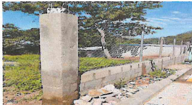
Foto 2: Muro perimetral y reforzamiento de columnas intermedias.
